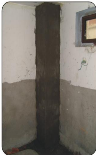
管弄井粉刷实景图
