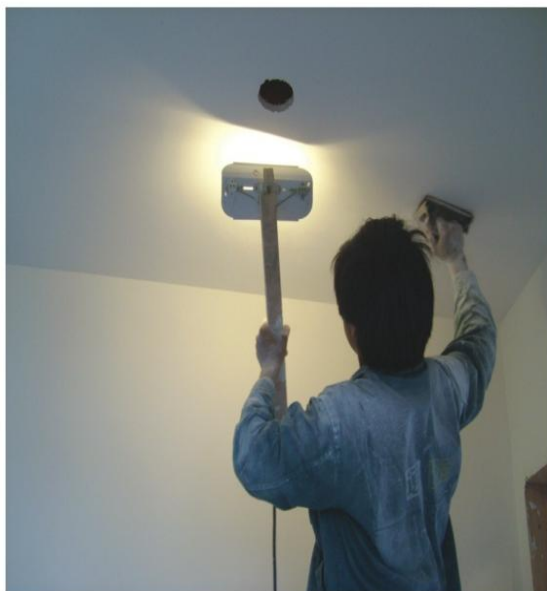
墙面打磨实景图
