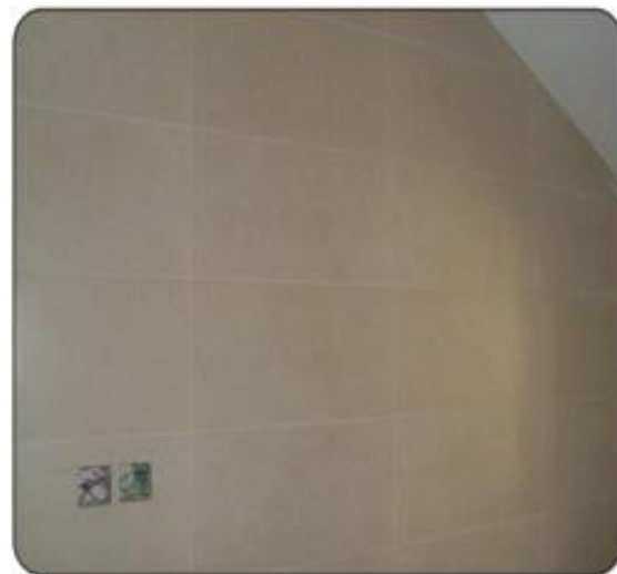
墙面瓷砖铺贴实景图
