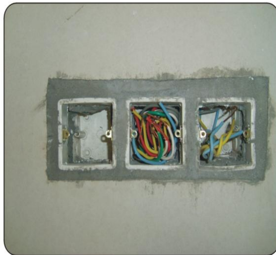
线盒粉刷实景图
